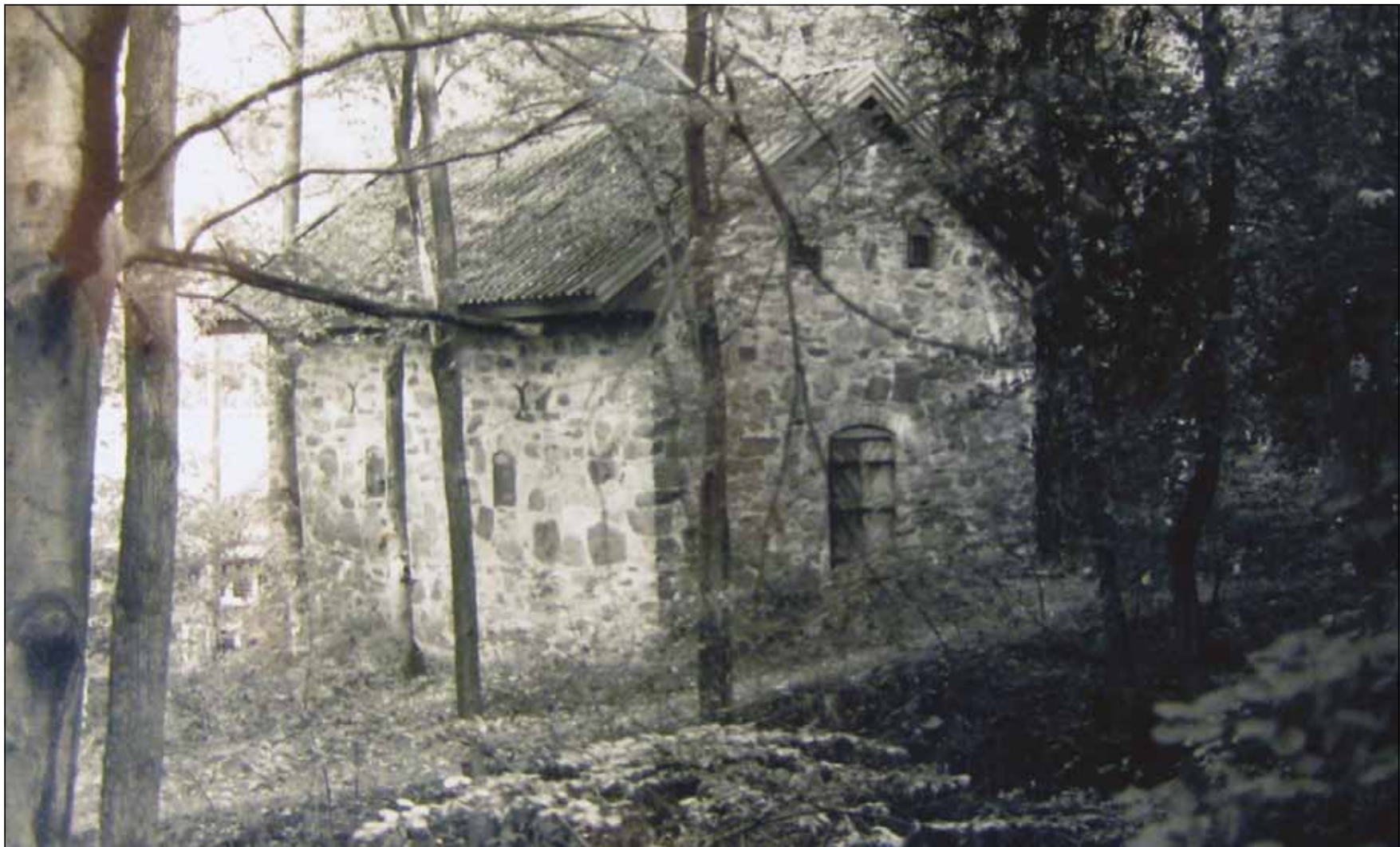
MATNYT-TIGT. Det månghund- raåriga visthuset – matför- rådet – står i Delsjöna- turen kvar, tillsynes likadant som under gross- handlare Prytz epok som ägare av Stora Torp under 1800-ta- lets första dryga tredjedel. Huvud- byggnaden, ett pampigt trähus, brann dock ner 1871 och där byggdes på samma plats Stora Torps slottlika ännu vack- ert sedda vita villa.
