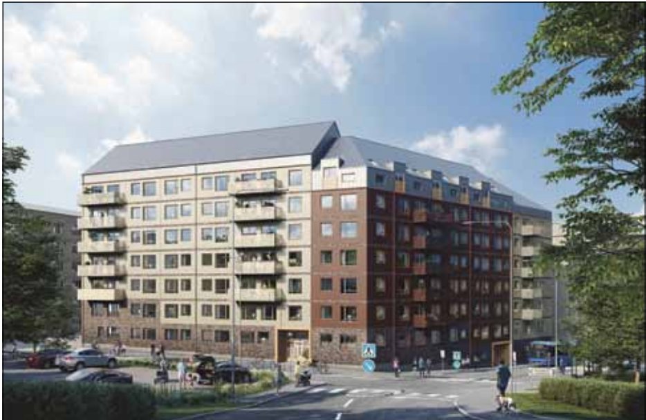
KVARTERET TERRASSEN med 165 hyresrätter på 1–4 rum och kök är nu under byggnation i Kallebacks Terrasser. Lägenheterna, som ligger nära skogen, kommunikationer och områdets terrasspark, ska stå klara till Göteborgs 400-års jubileum 2021.
