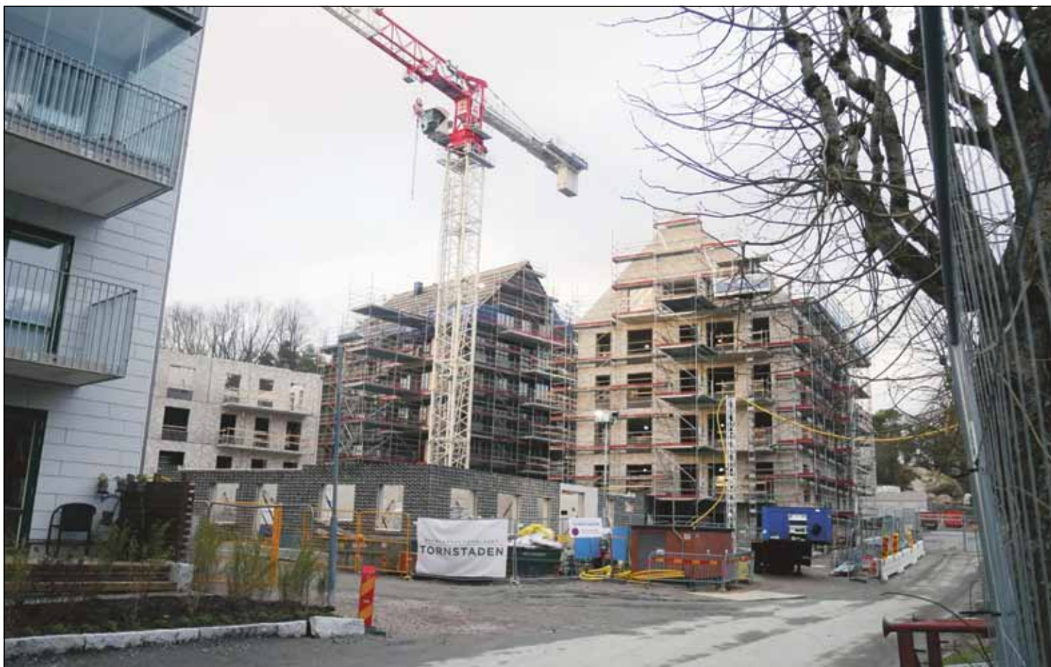
STADSDELEN VÄXER. Östra Kålltorp växer så det knakar – här ett bygget vid Virginsgatan.
