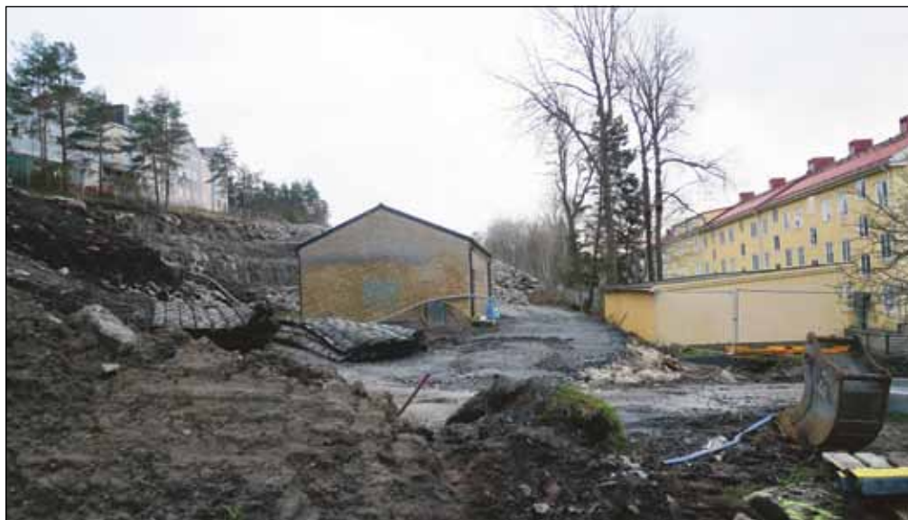
FÖRARBETE PÅGÅR. Så här ser bygget vid Qvidingsgatan ut just nu.
