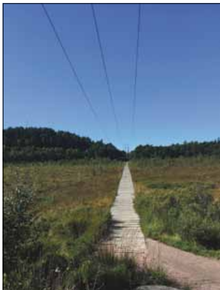
Spången över Svedsmossen som snart skall/måste renoveras, R40 går i överkant av bilden.
