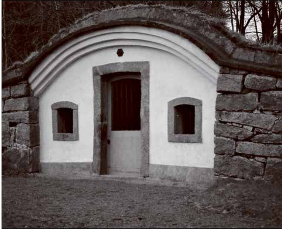
KÄLLA TILL HISTORIEN. Brunns huset vid Kallebäck's källa ritades av arkitekt Carl W Carlberg, avliden 1814 och begravd alldeles vid Örgryte Gamla kyrkas bakvägg.
