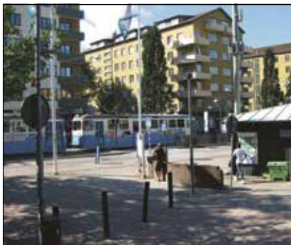
SLIT OCH SLÄP. Tunga spårvagnar med släp har ansträngt och slitit på betongplattan under rälsen, så det blir arbete hela sommaren med att byta till ny platta.
