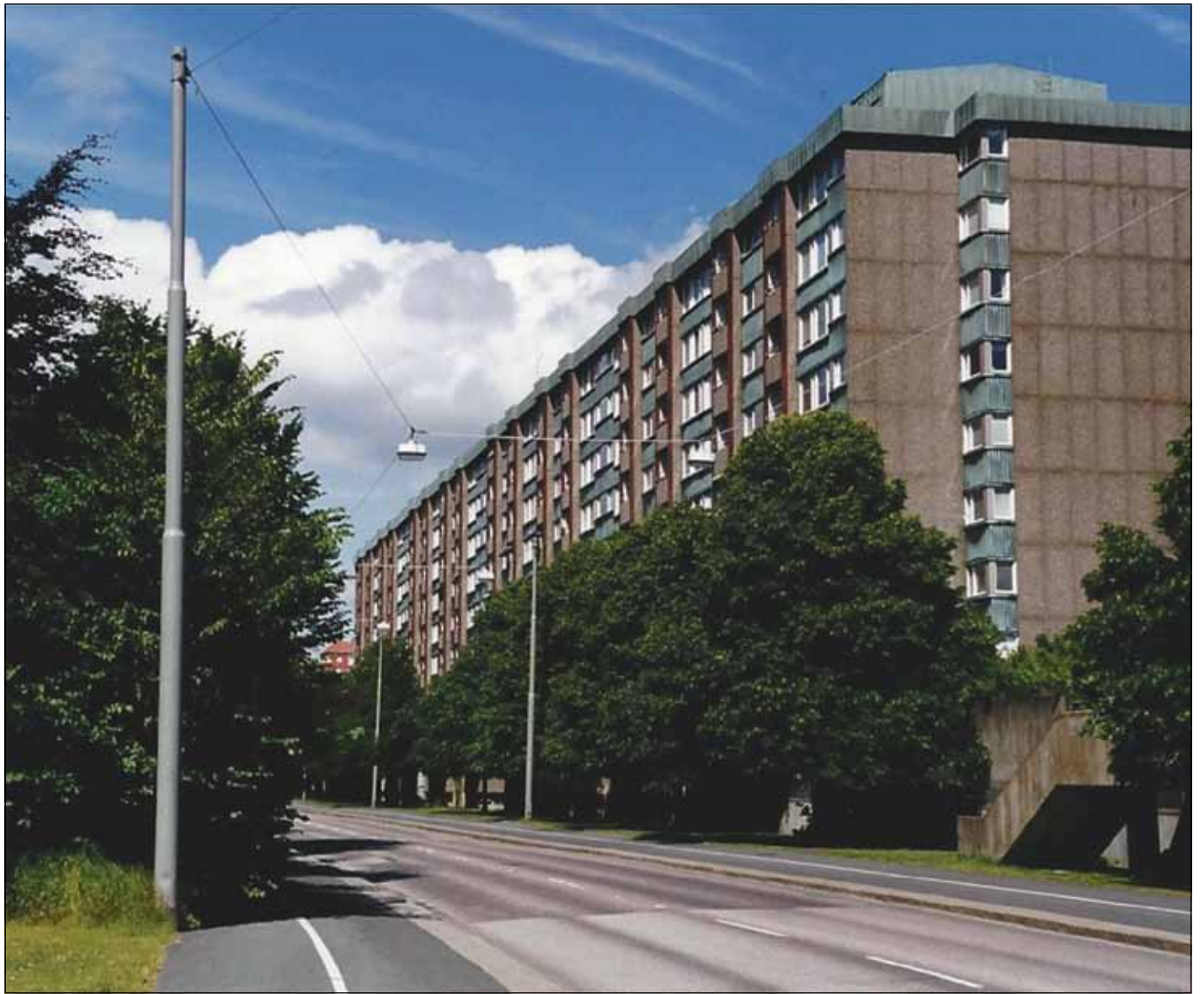
SKELETT-FRITT. Det är i princip omöjligt att benknotor efter mäster Johan, som ägde Lundens gård på 1600-talet, skulle finnas under Prästgårdsängens höga moderna hus intill Danska Vägen. Man schaktade vid byggandet avsevärt djupare än vanligt gammalt gravdjup.
